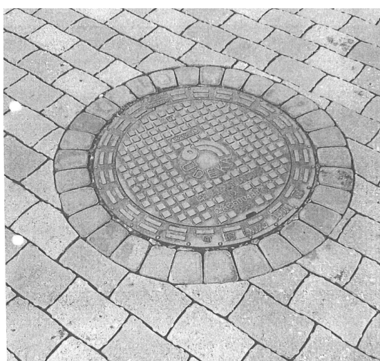
5.attēls. Aku vāku apbruģēšanas piemērs
